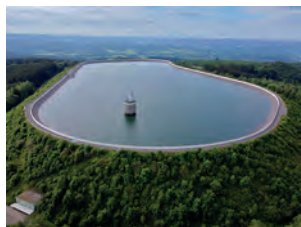
Beeindruckende Perspektive: das Pumpspeicherbecken in Rönkhausen
